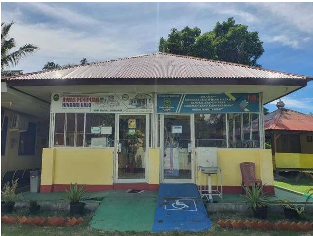
Tampak Depan Ruang PTSP Pengadilan Agama Mukomuko
